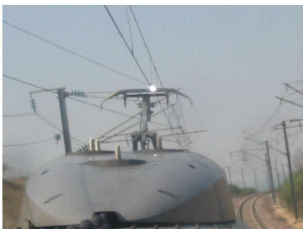
Figure 1 : Arc électrique généré entre le pantographe et la caténaire.
