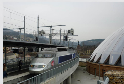
Quais TGV rénovés en gare de Bellegarde
