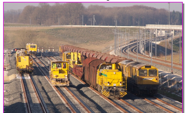
GENEUILLE durant les travaux
