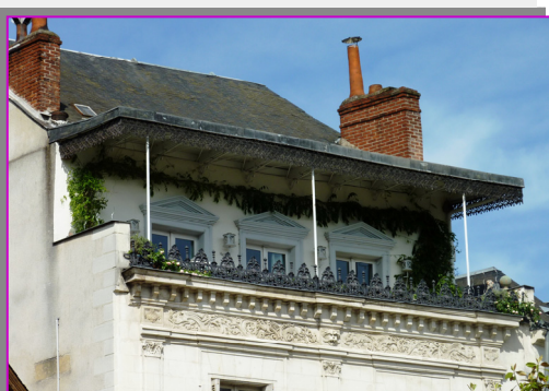
Belle bâtisse à Tours
